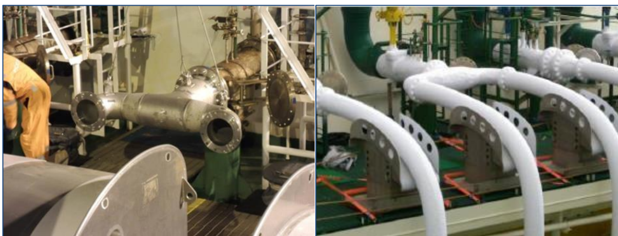
Slika 26 Postavljanje redukcijских spojeva
